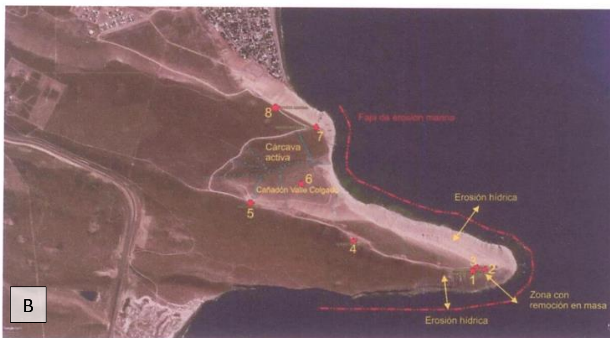
Figura N° 11.A y B. Procesos de erosión hídrica, marina y remoción en masa en la Punta Marqués.
